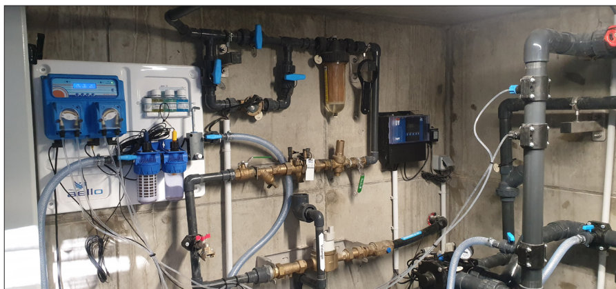
Local technique actuel avec la désinfection de l'eau au chlore
